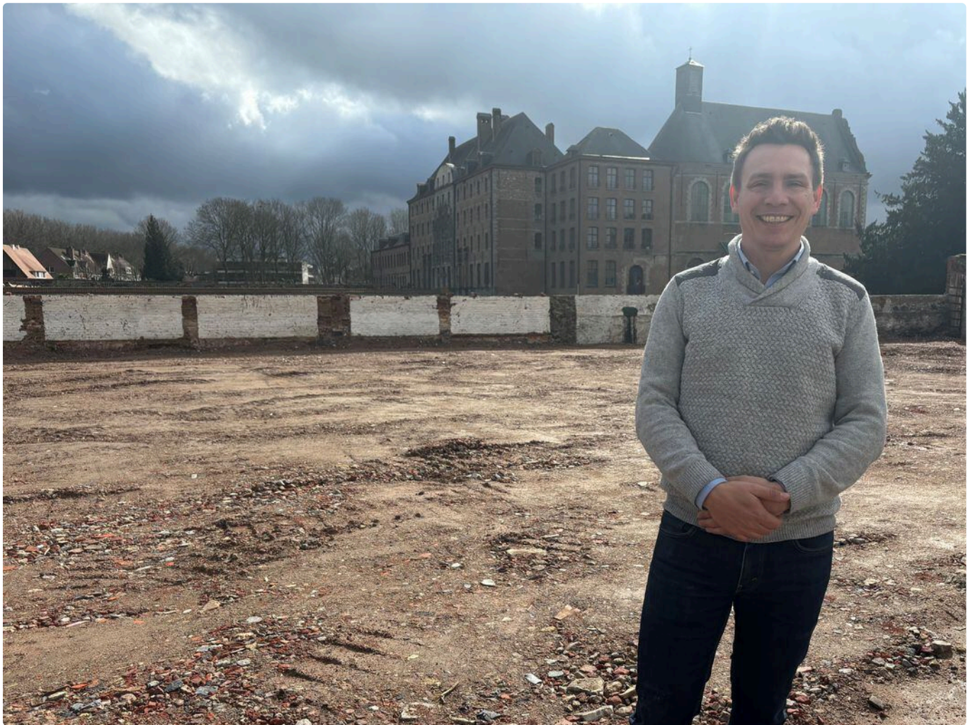
La phase de construction devrait démarrer au mois de mai de cette année. ©EDA
